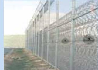
Detector de vibración de malla
