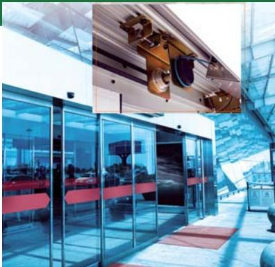
Alse Argentina presenta un operador de puertas diseñado en un kit modular que permite una instalación sencilla en nuevas construcciones o reformas en edificaciones existentes.
